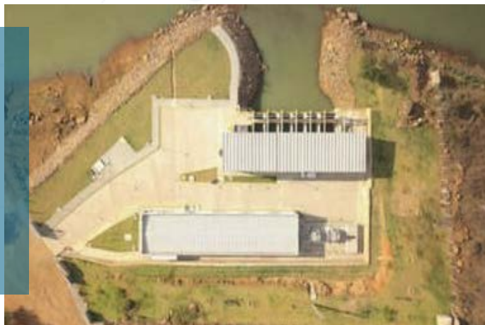
Adutora do Agreste/PE
