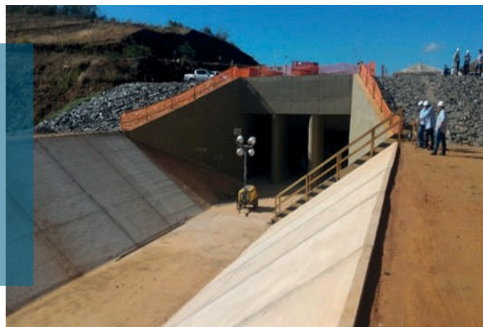
Cinturão das Águas/CE – Trecho 1
